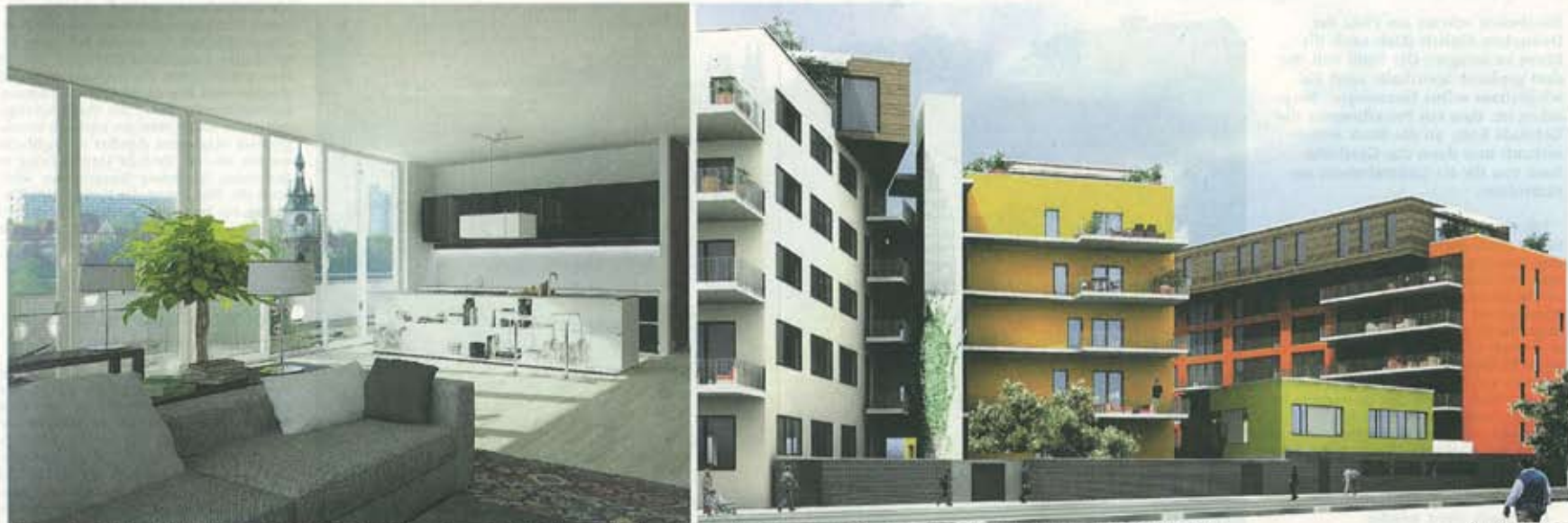
Die Bestandsgebäude der Friedel-Lofts sollen bis Oktober 2011, der Neubau (rechts) bis März 2012 fertiggestellt sein. Das Farbkonzept der Fassaden ist eine Anspielung auf die Sorten der Ahoj-Brause.
